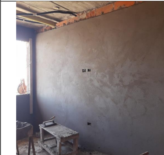
PISO 19: MUROS DE ASCENSOR 100%. LEVANTE DE MAMPOSTERIA PASILLOS
