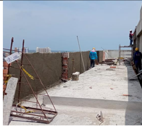
PISO 20: LOSA PISO 20. LEVANTE DE MAMPOSTERIA PROTECCION VACIOS, ANTEPECHOS PERIMETRALES
