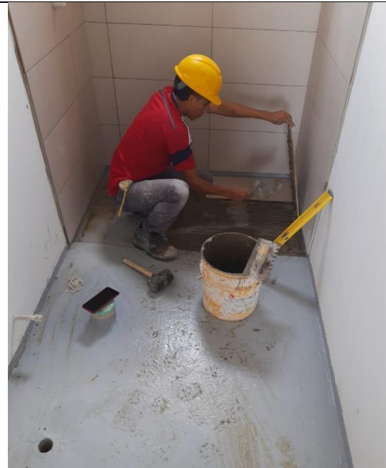
PISO 13: INSTALACION DE PISOS Y PATERAS DE ENCHAPES. IMPERMEABILIZACION EJECUTADA AL 100%
