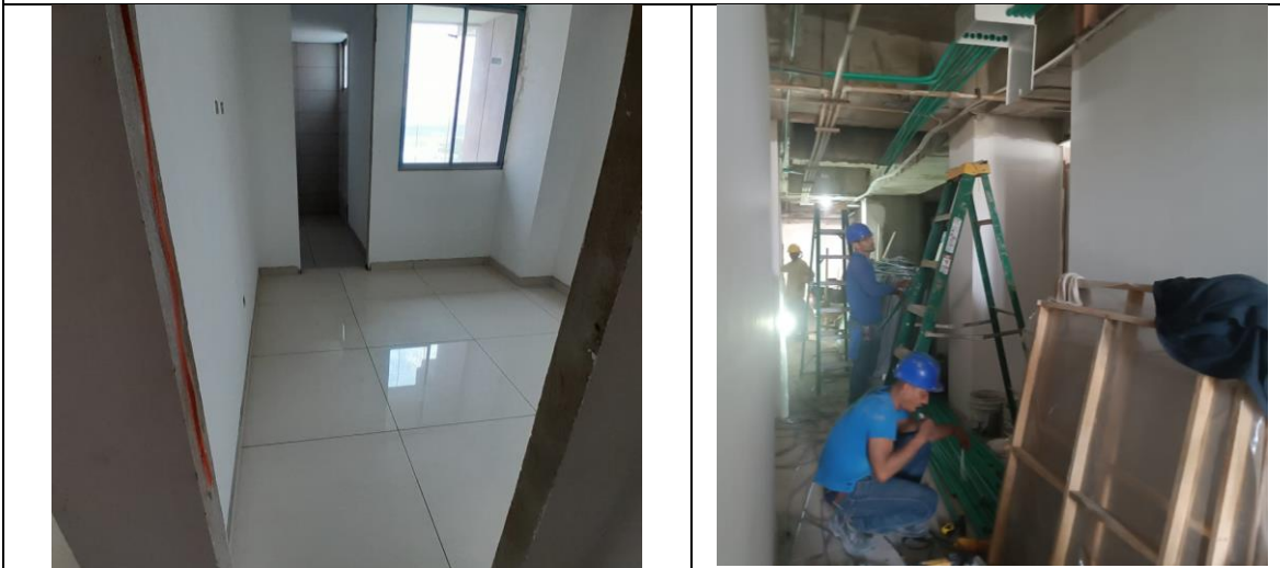
PISO 9: INSTALACION DE VENTANERIA EN PROCESO DE INSTALACION. PASILLOS INSTALACION DE TUBERIA DESCOLGADA DE REDES ELECTRICAS
