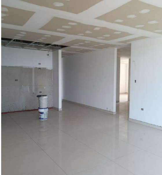
PISO 12: MASILLADO DE CIELO RASO Y PRIMERA MANO DE PINTUURA, INSTALACION DE LAMINAS DE CIELO RASO EN ZONAS HUMEDAS
