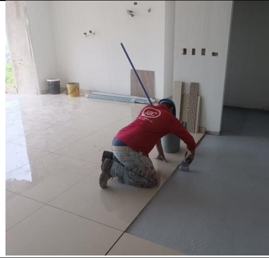
PISO 14: APLICACIÓN DE IMPERMEABILIZANTE EN ZONAS HUMEDAS
