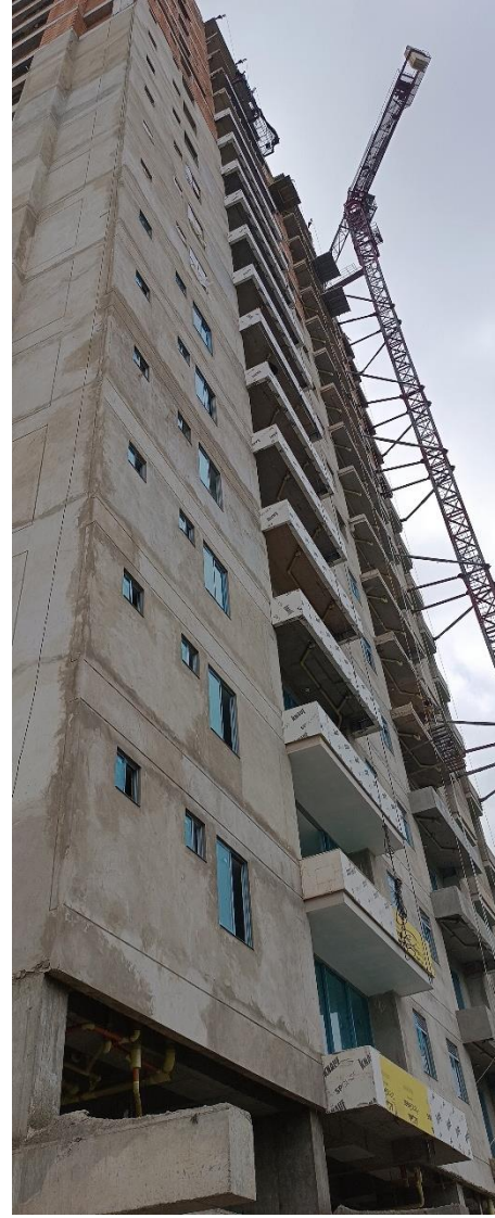
FACHADA SUR: EJECUCIÓN DE PAÑETES. INSTALACIÓN DE FALDONES EN BALCONES. VENTANERIA PISO 2 AL 7
