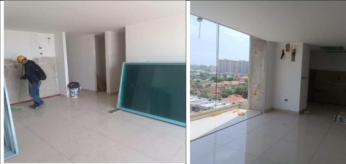
PISO 10: PROCESO DE INSTALACION DE VENTANERIA, 1ERA MANO DE CIELOS
