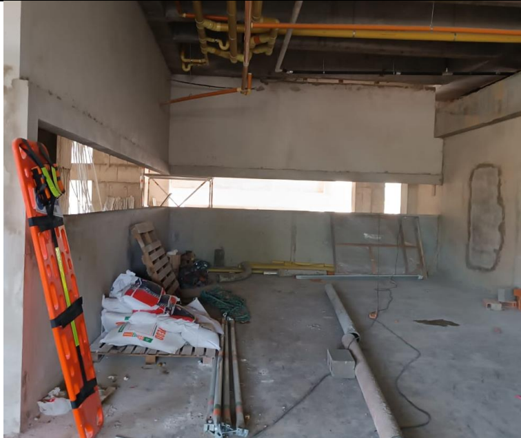
LOBBY: PISO 1 ADECUACION ZONA DE PARQUEADEROS
