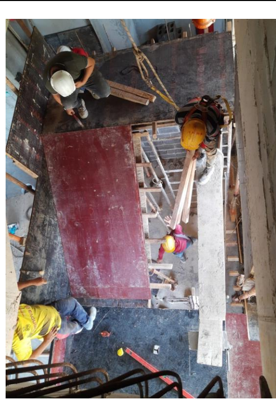
PISO 1: ARMADO DE ESTRUCTURA PARA ESCALERA LOBBY A PISO 2
