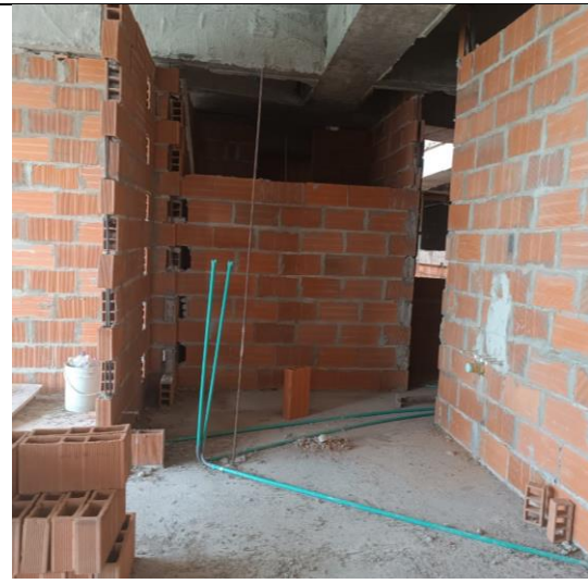
PISO 19: LEVANTE DE MAMPOSTERIA EN APARTAMENTOS EN PROCESO DE EJECUCION
