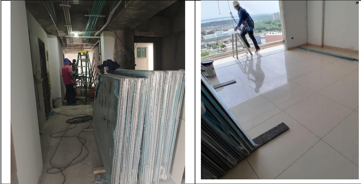
PISO 8: INSTALACION DE CIELO EN BALCONES, VENTANERIA EN PROCESO DE INSTALACION. DESCOLGADAS EN PASILLOS DE ZONAS COMUNES.
