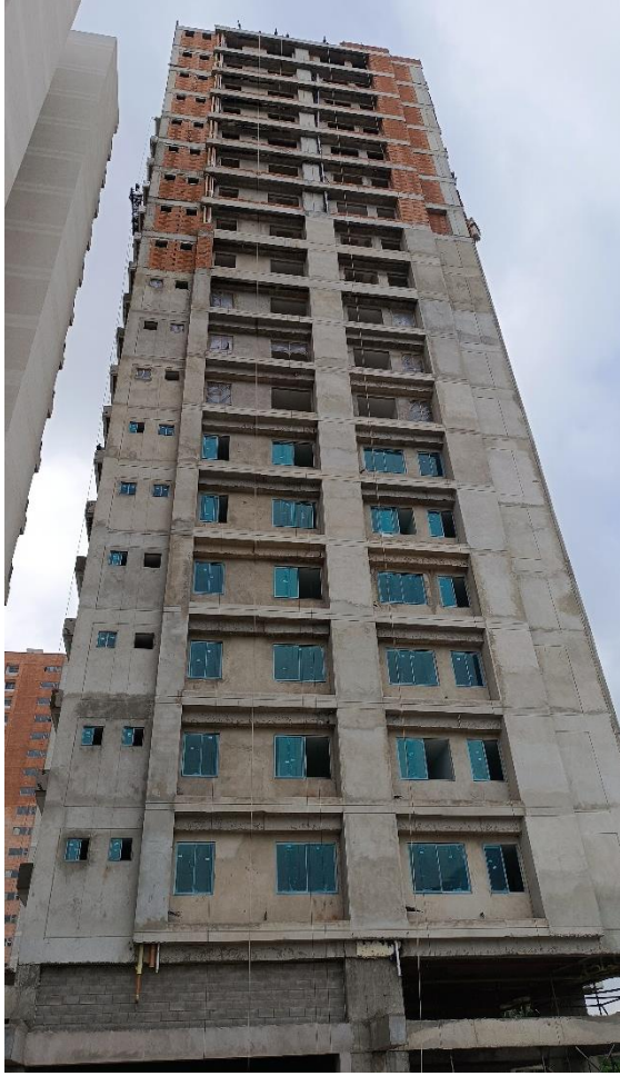
FACHADA ESTE: EJECUCION DE PAÑETE DE FACHADA Y MAMPOSTERIA DE BUITRONES. INSTALACION DE VENTANERIA PISO 2 AL 7
