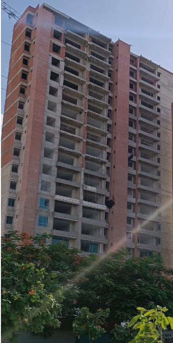
FACHADA NORTE: EJECUCIÓN DE PAÑETES. INSTALACIÓN DE FALDONES EN BALCONES. VENTANERIA PISO 2 AL 7
