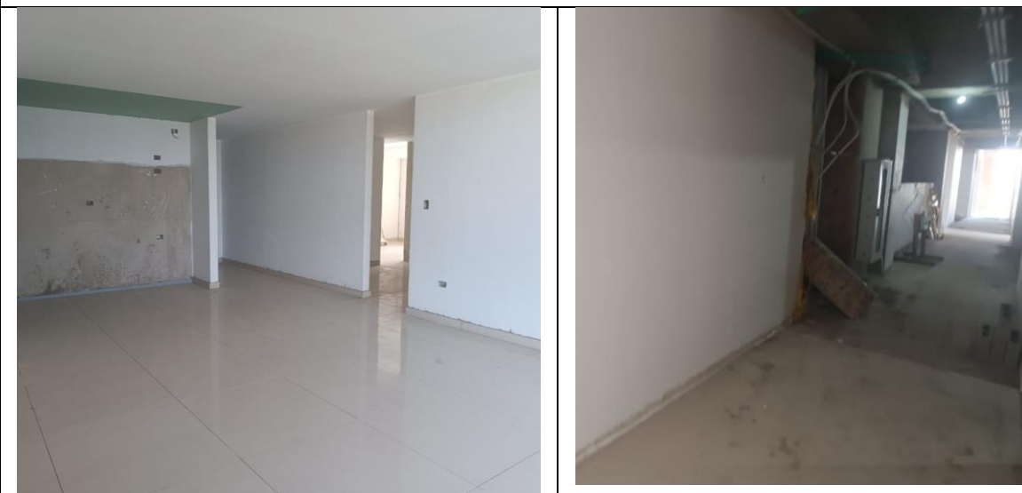
PISO 11: PISOS INSTALADOS, INSTALACION DE LAMINAS DE CIELO EN ZONAS HUMEDAS, POSTERIOR A IMPERMEABILIZACION DE PISO SUPERIOR. PASILLOS CON ESTUCO Y PRIMERA MANO DE PINTURA
