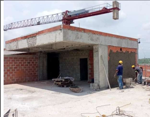
PISO 20: ESTRUCTURA 100% CUBIERTA DE SERVICIOS 100% ESTRUCTURA LEVANTE DE MAMPOSTERIA, EN PROCESO DE APLICACIÓN DE PAÑETE
