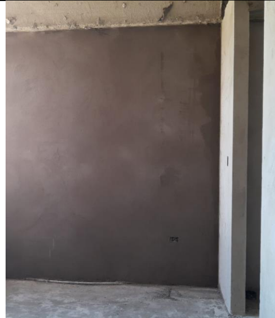
PISO 18: PAÑETE TERMINADO 100%
