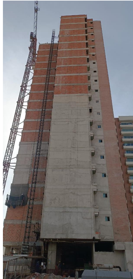
FACHADA OESTE: EJECUCION DE PAÑETE DE FACHADA. INSTALACION DE VENTANERIA PISO 2 AL 7
