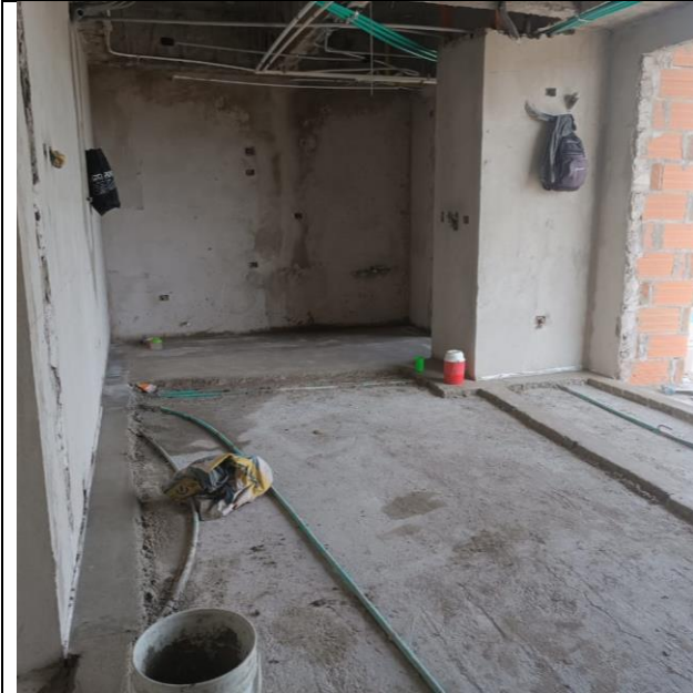
PISO 18: EN PROCESO DE APLICACION DE PLANTILLAS
