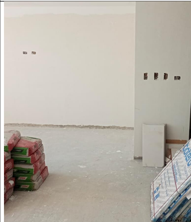
PISO 15: PREPACION DE PISO PARA INSTALACION DE PORCELANATO
