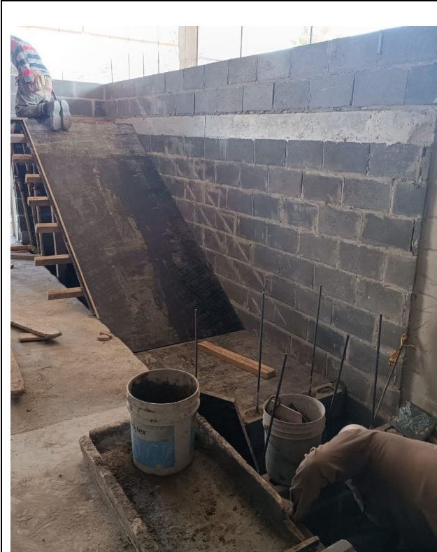
PISO 1: ARMADO DE ESTRUCTURA PARA ESCALERA LOBBY A PISO 2
