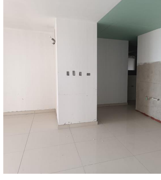
PISO 12: MASILLADO DE CIELO RASO Y PRIMERA MANO DE PINTUURA, INSTALACION DE LAMINAS DE CIELO RASO EN ZONAS HUMEDAS
