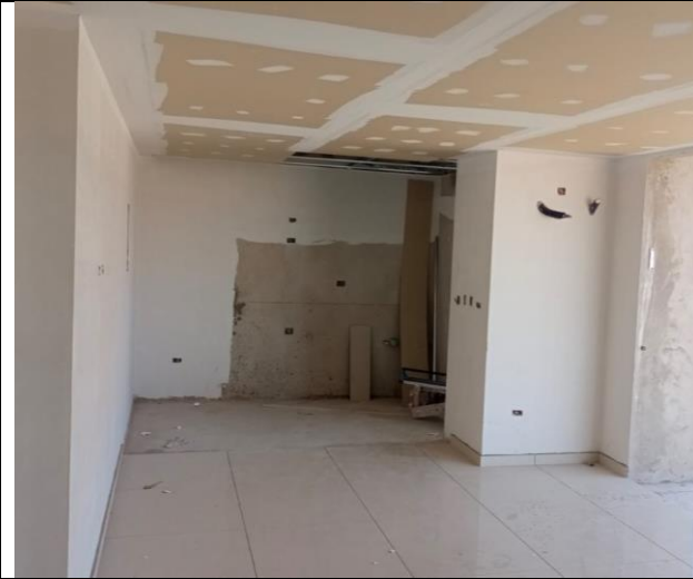
PISO 14: INSTALACION DE LAMINAS DE CIELO RASO Y MASILLADO
