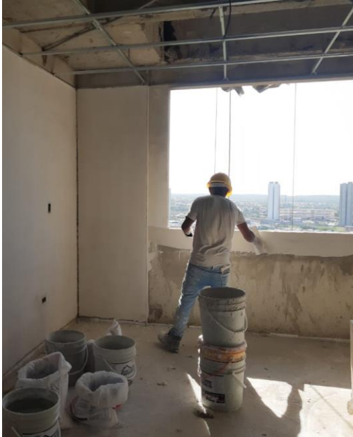
PISO 16: APLICACIÓN DE ESTUCO EN MUROS INTERNOS DE APARTAMENTOS Y PARRILLA DE CIELO RASO
