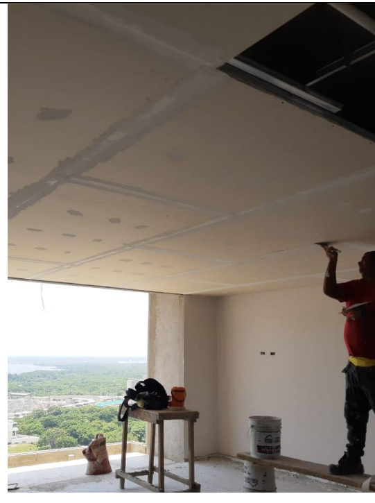
PISO 15: APLICACIÓN DE MASILLA EN LAMINAS DE CIELO RASO
